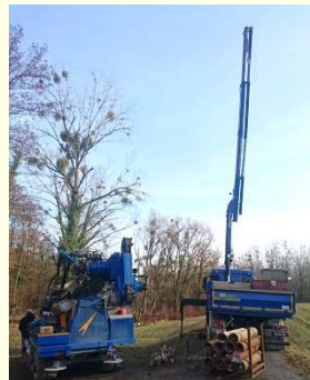
Mit Bohrgeräten werden die geotechnischen Erkundungen durchgeführt.
